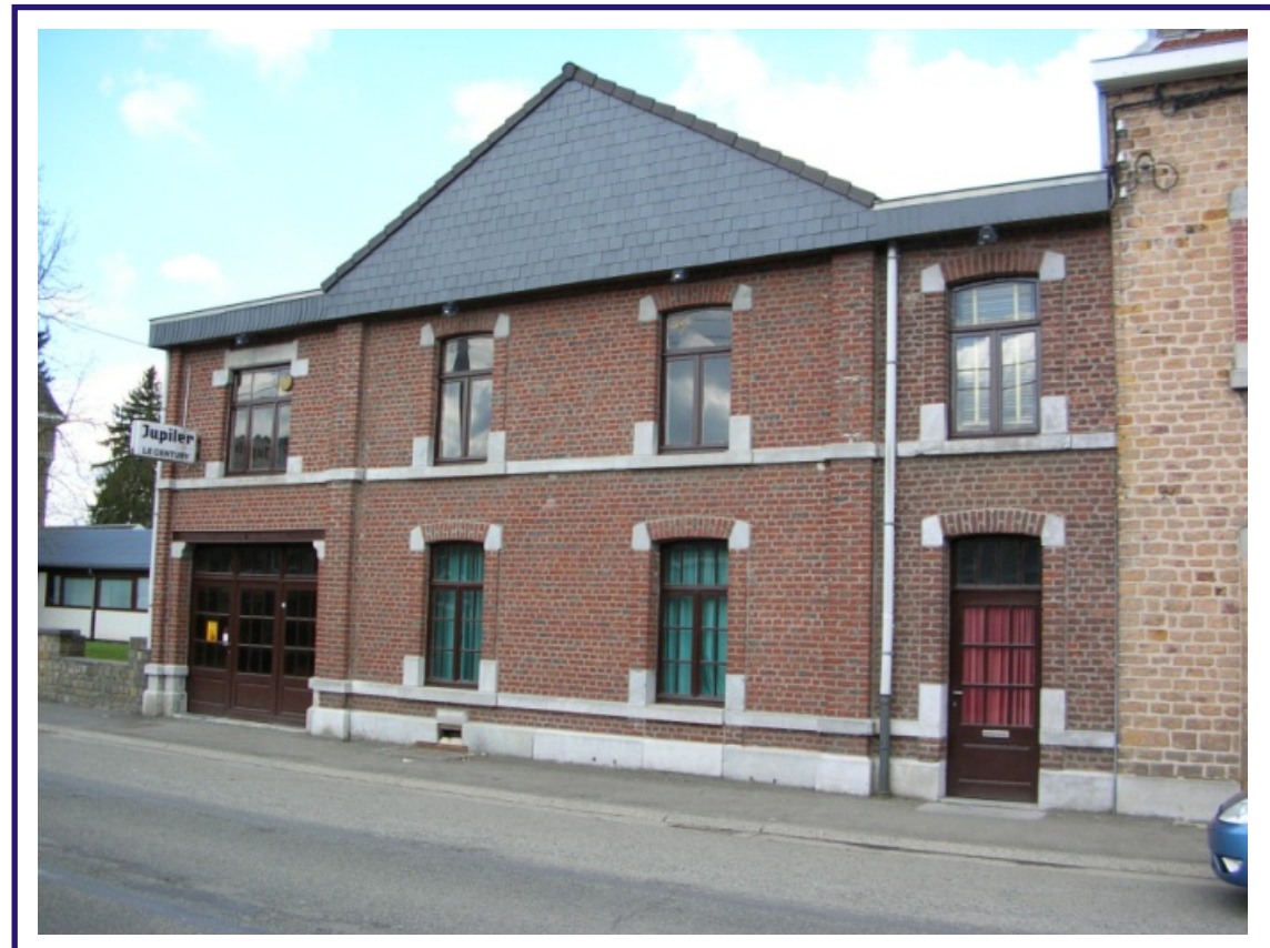
Les travaux terminés
